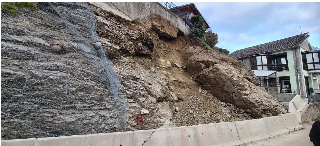
Vista della frana con posizionamento dei NEW JERSEY a protezione del passaggio in emergenza
